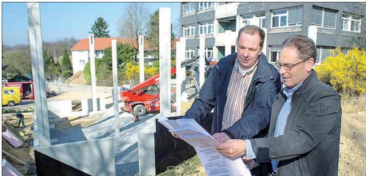
Uwe Meyer (li.) und Projektleiter Frank-Michael Widholm (re.) vor der Baustelle des neuen Lebenshilfe-Lagers an der Heidestraße in Wuppertal-Cronenberg. Fotos (3): Marcus Müller
