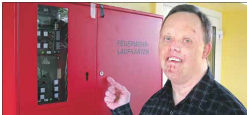
Klaus Kaiser vor der neuen Brandmeldeanlage Foto: Mainzer
